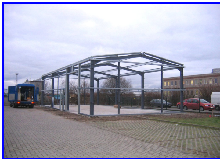
Der FormI Qualitätsanspruch: Massive Stahlrahmen aus geschweissten IPE-Profilen Pfetten- und Wandriegelanlage aus verzinktem Stahl
